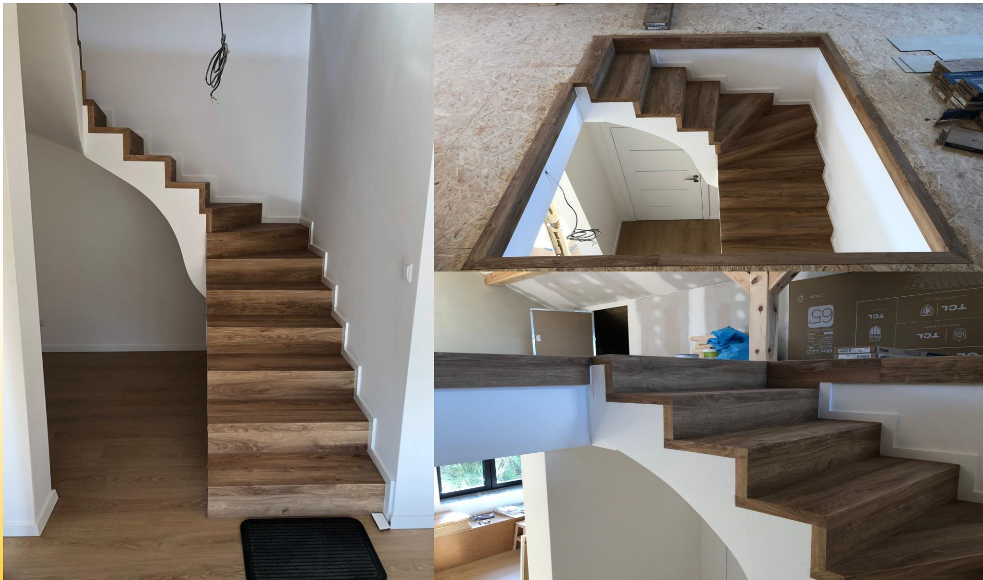
Rodinný dům Pohořelice – materiál: Vinyl TARKETT, profil SIMPLE L, napojení podlahy profilem SF125
