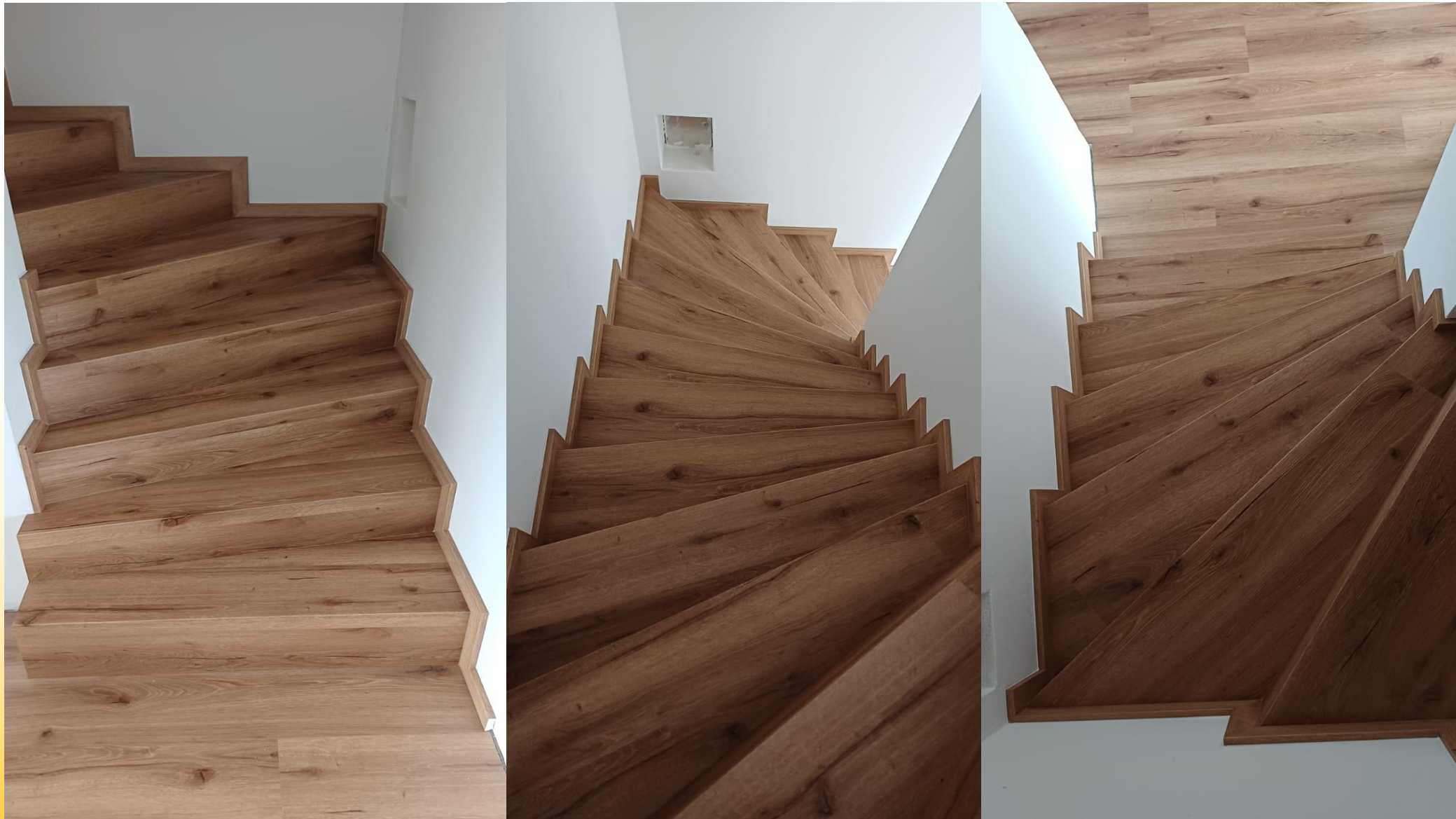
Rodinný dŕm Veltrusy – materiál: vinyl, profil SIMPLE L
