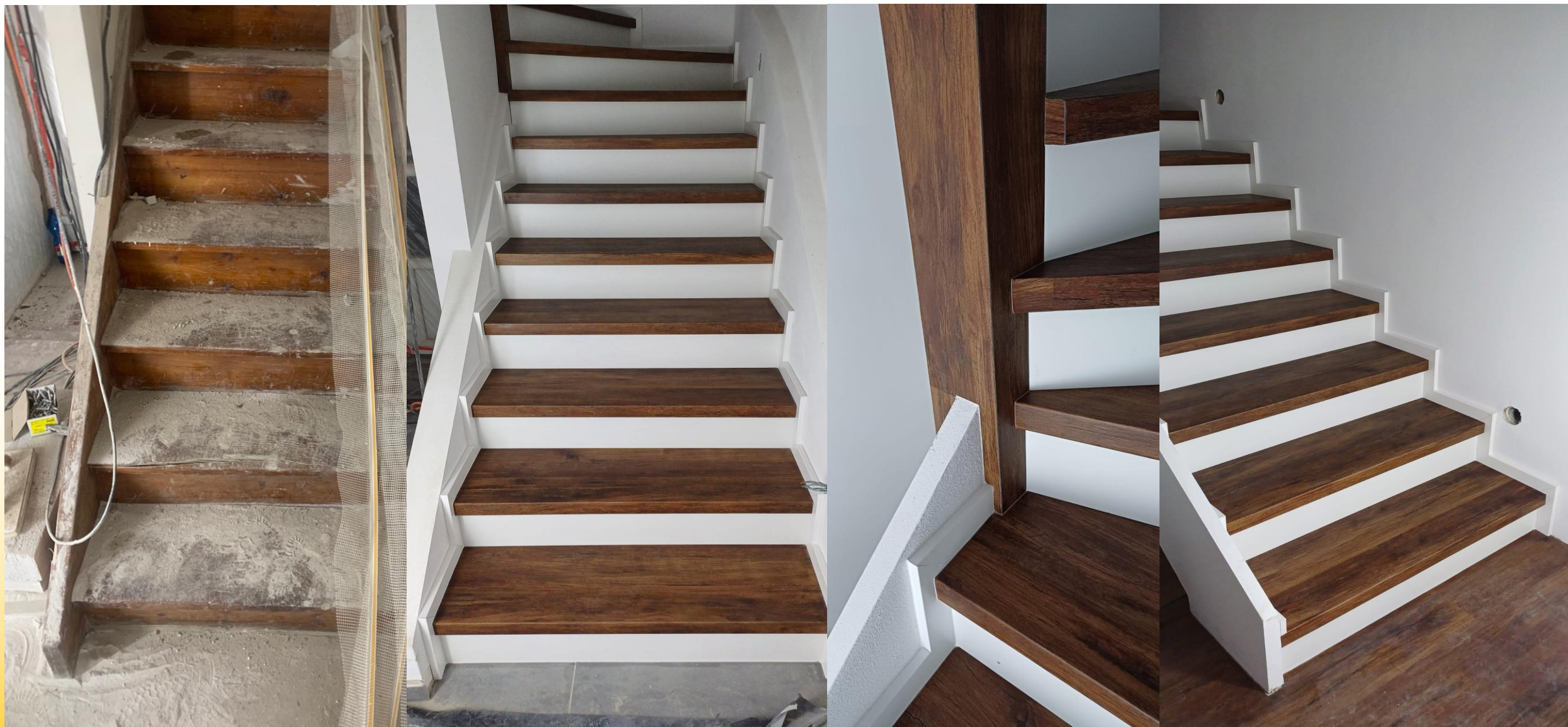
Rodinný dům Praha 6 – materiál: vinyl THERMOFIX, profil SF-40, bílé podstupnice a bílé soklové lišty
