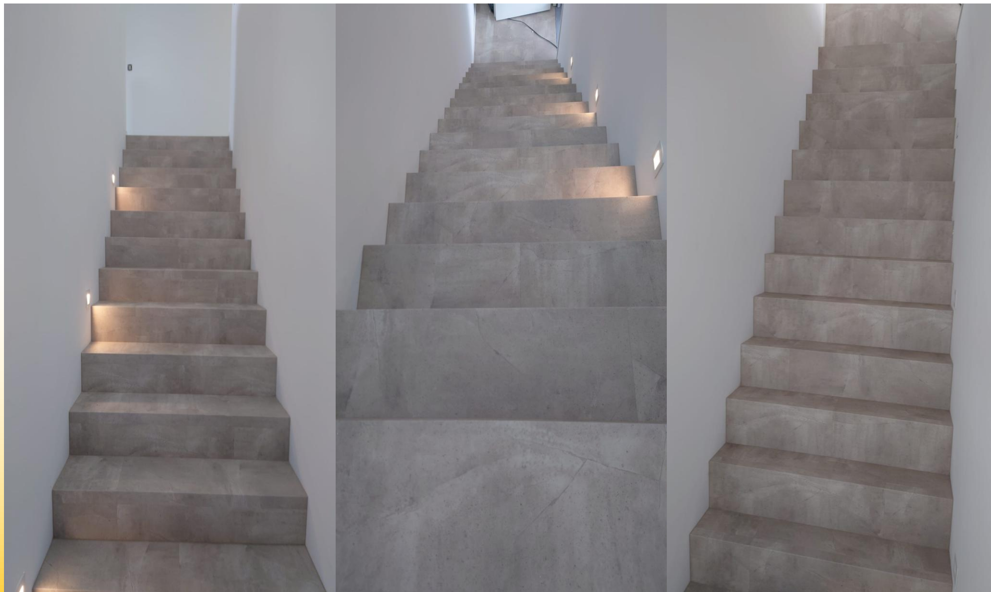
Rodinný dům Chemnitz D – materiál: vinyl GERFLOR, profil SIMPLE L
