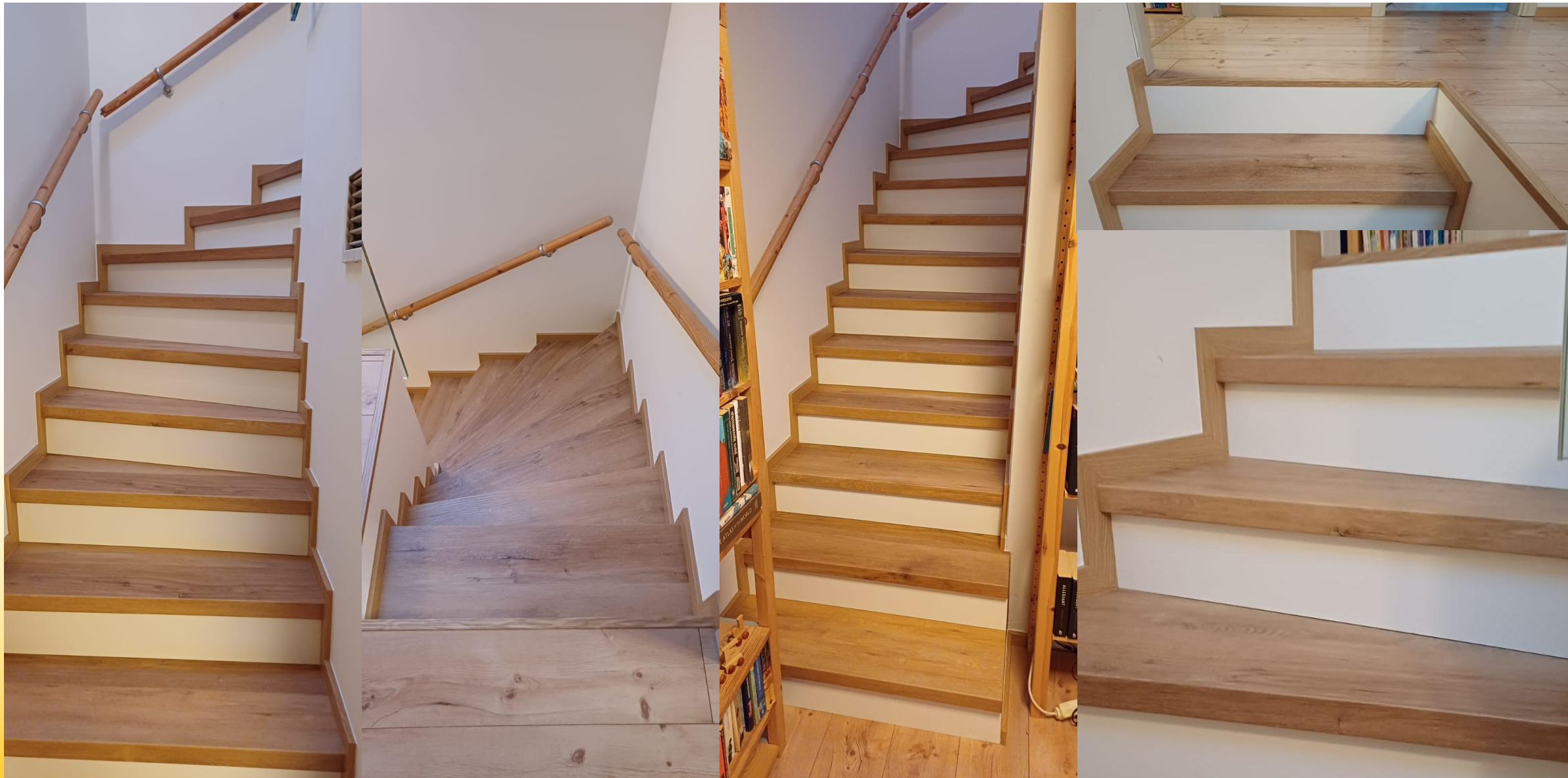
Rodinný dům Vrané nad Vltavou – materiál: vinyl NEMOFLOOR, profil SF40 + bílá podstupnice
