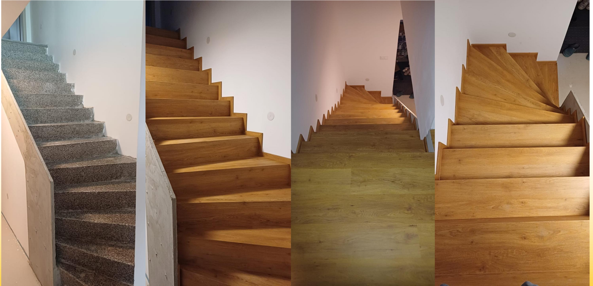
Rodinný dům Chocẽ – materiál: vinyl BERRY ALLOC, profil SIMPLE L
