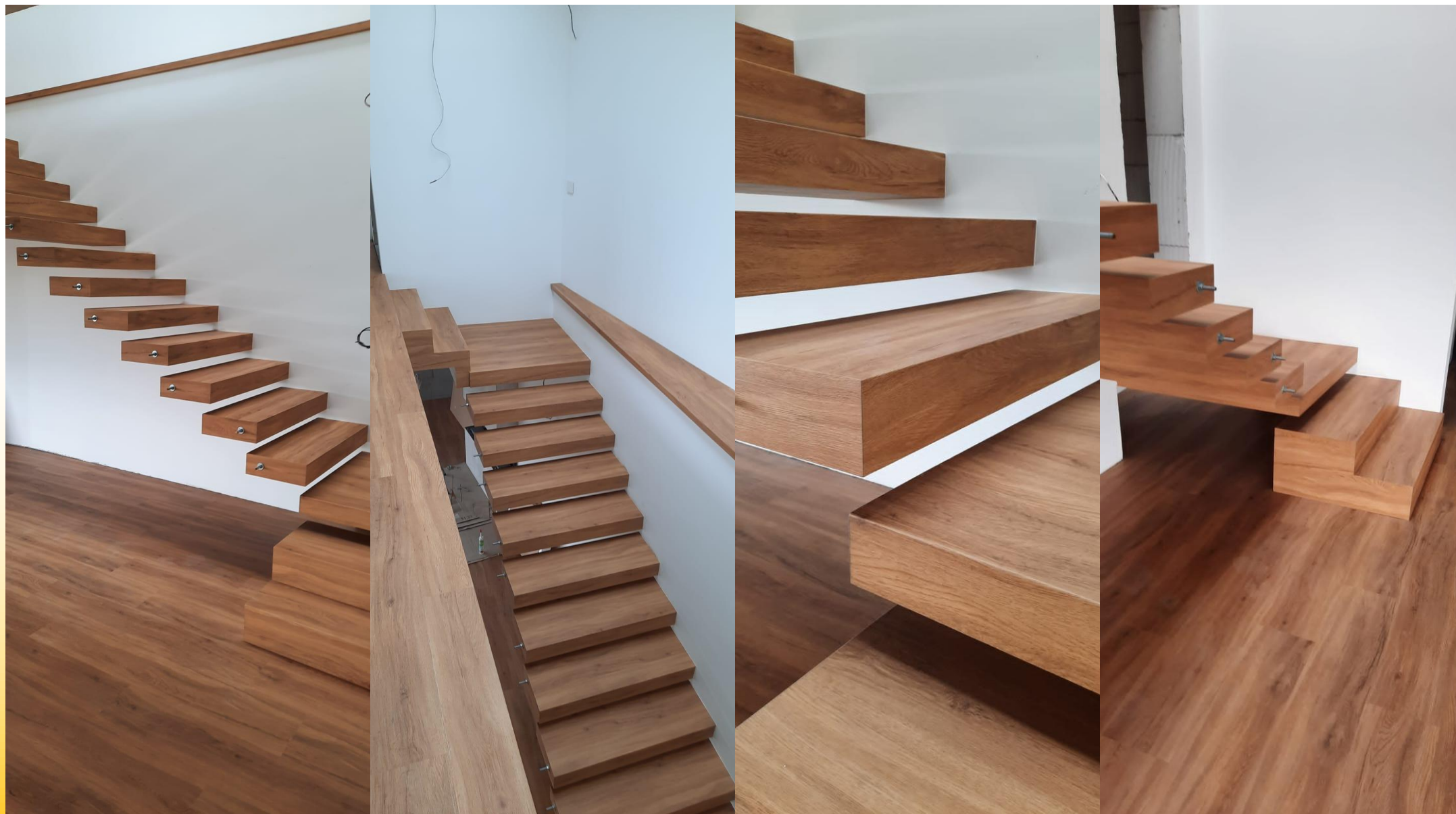
Rodinný dům Lelekovice – materiál: vinyl PARADOR, návlek levitující schodiště
